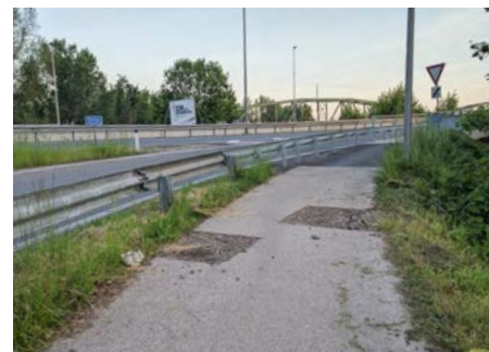
Vergleich: Steyreggerbrücke Linz ...
