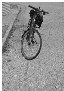
ter ausgebessert. Die Ausbesserung war nötig, da sich an dieser Stelle häufig Regenwasser über einen langen Zeitraum gesammelt hat. Die Ausbesserung wurde aber auf Kosten der Fahrqualität der Fahrradfahrer gemacht, da die Sturzgefahr dadurch erheblich höher ist.
