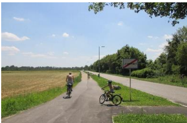
Der neue Radweg in der Alleestraße
