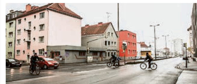
Sommer. Entlang des Eggenberger Gürtels – von der Friedhofsbis zur Custozzagasse – entsteht im Sommer ein neuer Radweg. Für den Autoverkehr bleibt alles beim Alten. HOFFMANN
