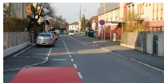
Augustinergarten mit Radfahrstreifen gegen die Einbahn: es ist kaum machbar, PKWs auf der markierten Parkspur abzustellen
