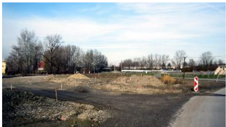
Blick vom Bahnübergang bei der Rollfähre in Richtung Norden. Am rechten Bildrand, kaum zu erkennen, befindet sich die Kläranlage, links hinter den hohen Bäumen das Öllager der Mol.
