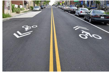
Bild 4: Sharrows leiten die RadlerInnen etwa in die Mitte der Fahrbahn, ein risikoreiches Überholen ist an dieser Stelle nicht erwünscht, das Linksabbiegen wird erleichtert (Bild: ORF ON)
