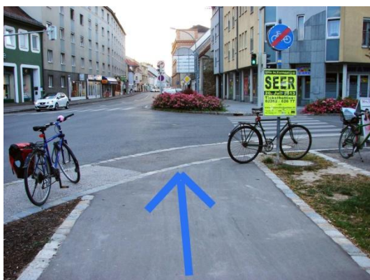
Bild 10: Blick von der Schubertstraße kommend in Richtung Stadtzentrum: der Radweg endet am Gehweg. Dieser Bereich wurde im Jahr 2011 neu, jedoch identisch wie zuvor, gebaut.
